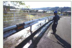
ガードレールの清掃
