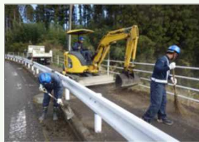
歩道に堆積した土砂の撤去
